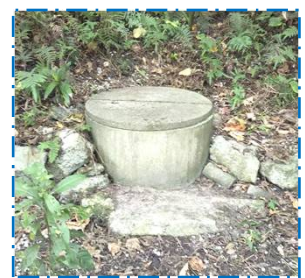
コンクリート製の井戸
